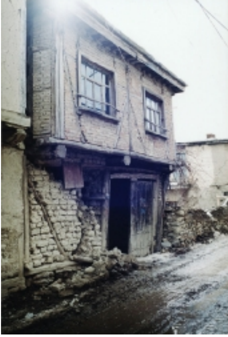
Resim 5. Eber’de, detayları hatalı geleneksel bir yapı
