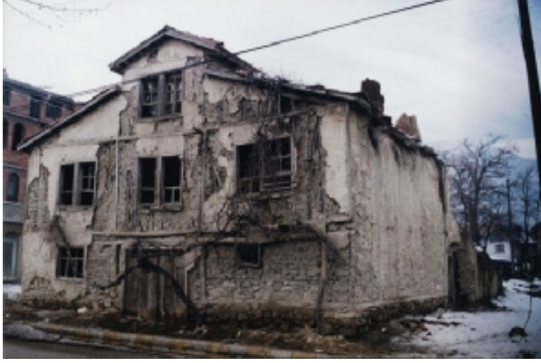
Resim 10. Çay ilçesinde, eski eser geleneksel bir yapı
