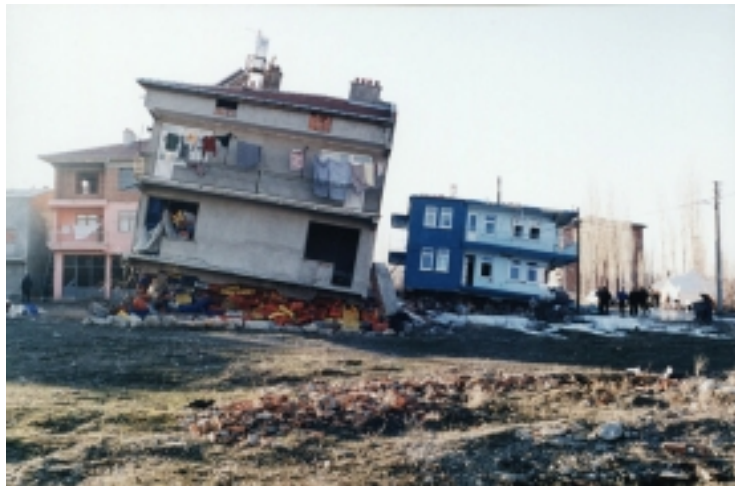
Resim 8. Çay ilçesi, Bolvadin yolu üzerinde hasarlı binalar
