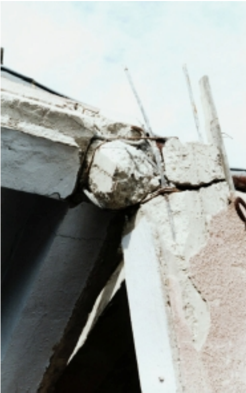
Resim 3, Resim 4. Çay ilçesi Sanayi Sitesinde hatasız bir kısmı olmayan hasarlı taşıyıcı sistem elemanları.
