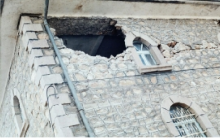
Resim 7. Yakasenek'te hasar gören bir camii
