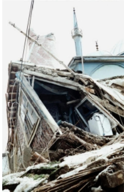
Resim 5. Eber’de üzerine minare devrilen bir yapı
