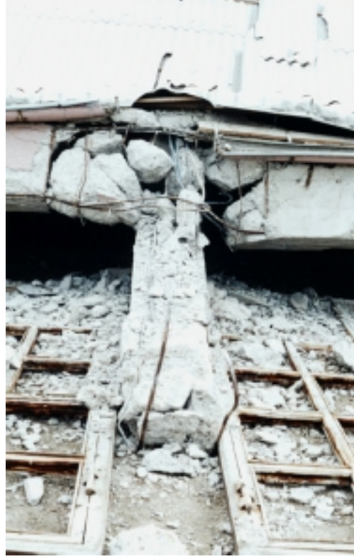
Resim 2. Çay ilçesi Sanayi Çarşısında etriyeleri dahi olmayan bir kolon
