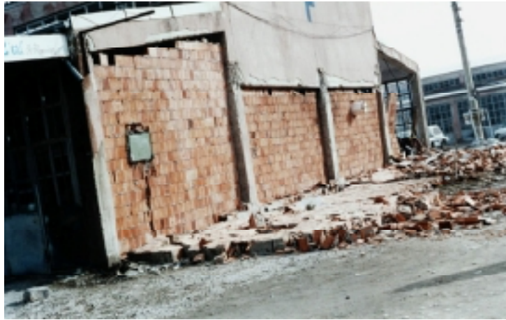
Resim 14. Tuğla duvarları yıkılmış bir bina. (Sanayi Çarşısı)
