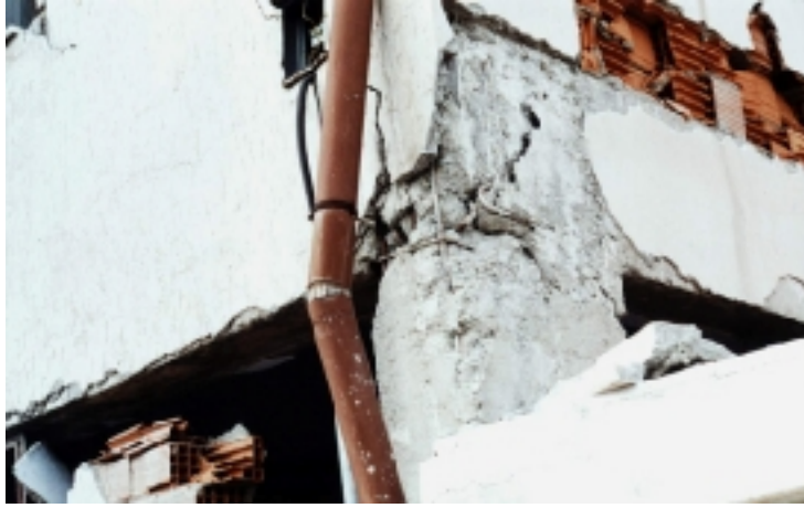
Resim 13. Caminin mafsallaşmış kolon-kiriş birleşimi
