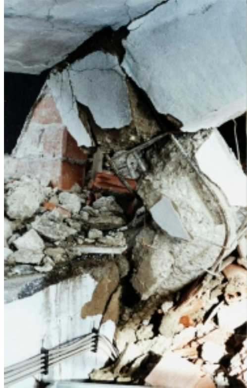
Resim 3, Resim 4. Çay ilçesi Sanayi Sitesinde hatasız bir kısmı olmayan hasarlı taşıyıcı sistem elemanları.
