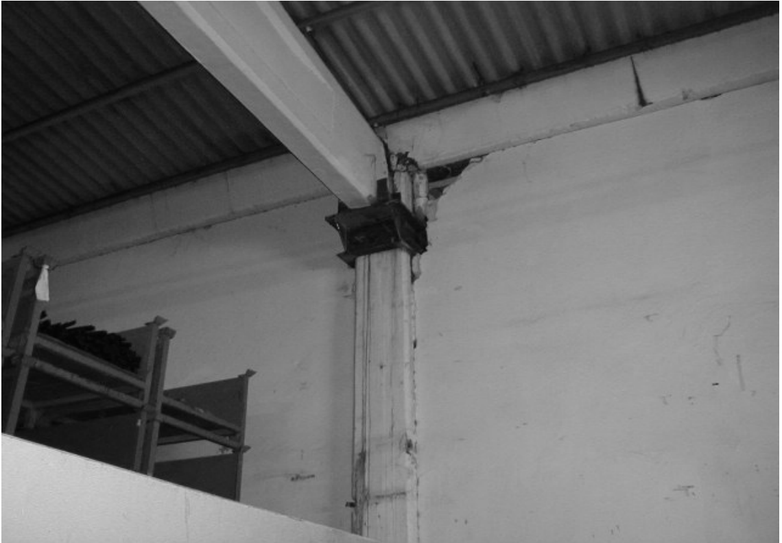
Şekil-3 Kirişler için alınan geçici tedbirler
