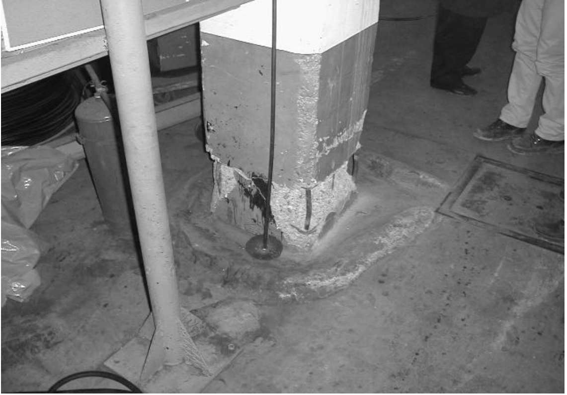
Şekil-4 Kolon hasarları
