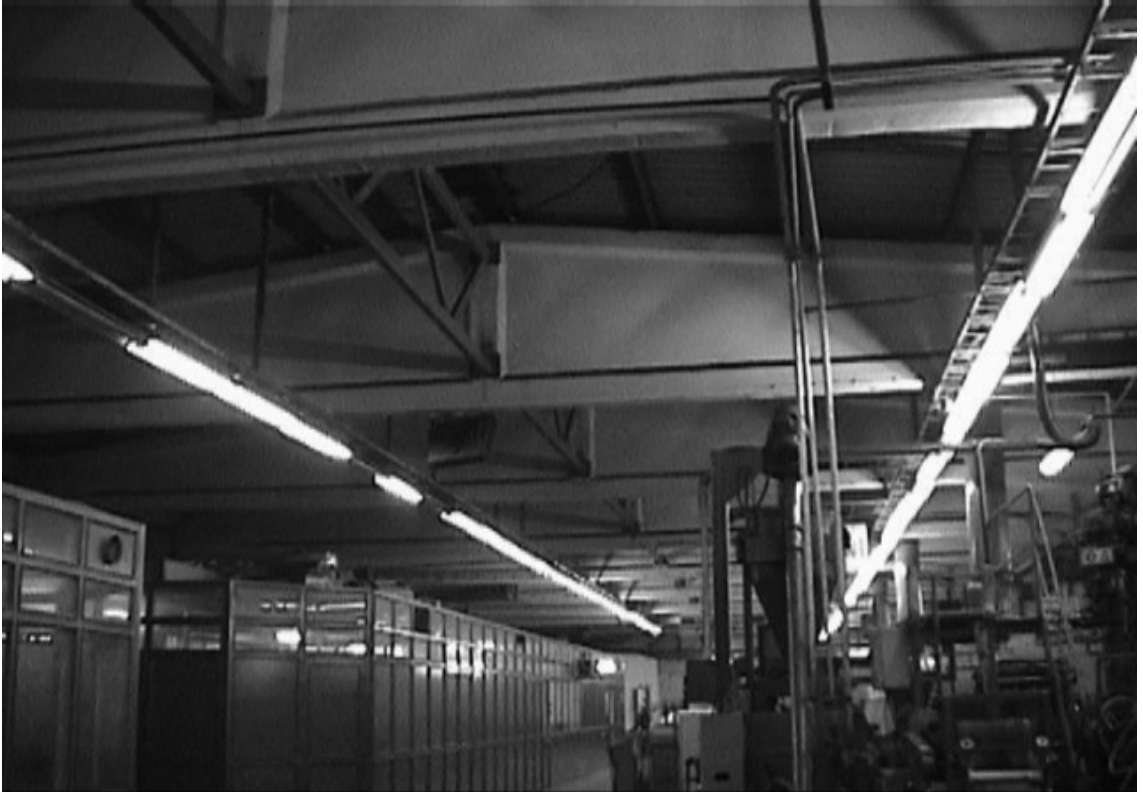
Şekil-9 Kiriş aralarında çelik makas sistemi
