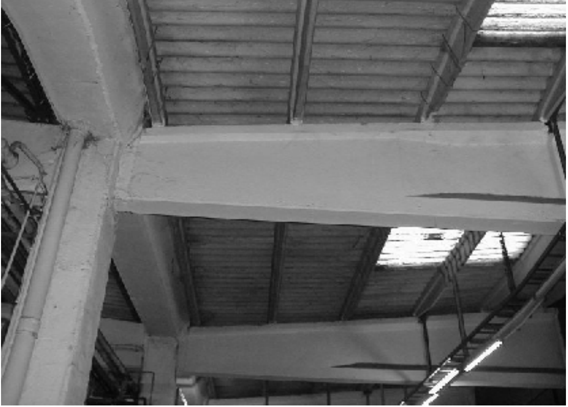
Şekil-2 Çatı Kirişlerinin kolona oturumu
